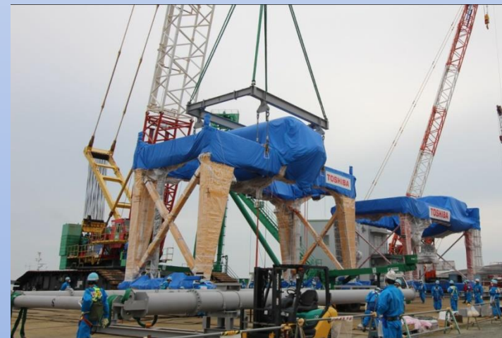
燃料を扱うクレーンと機械
