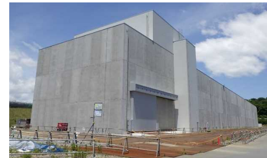
大型廃棄物保管庫 (2023年竣工予定)
