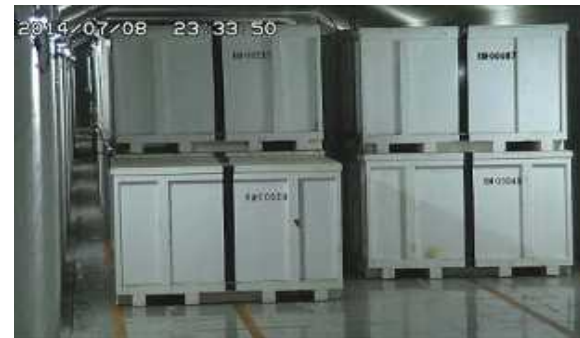
屋内コンテナ保管 (固体廃棄物貯蔵庫)
