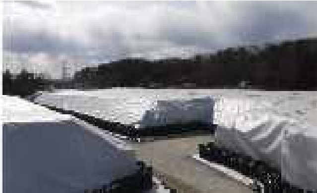
屋外シート養生
