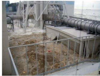
津波襲来 電源喪失
