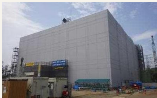
雑固体廃棄物焼却設備
