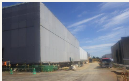
新廃棄物貯蔵施設
