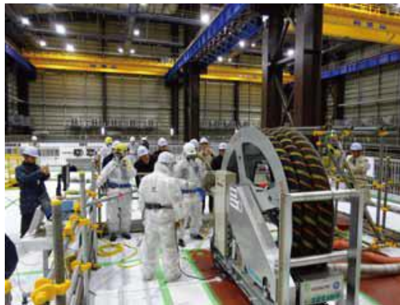
S/C脚部補強施工性確認試験
